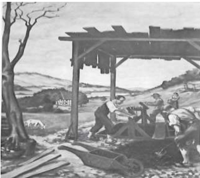
Abb. 5: Püttentwässerung mit der Handhaspel
