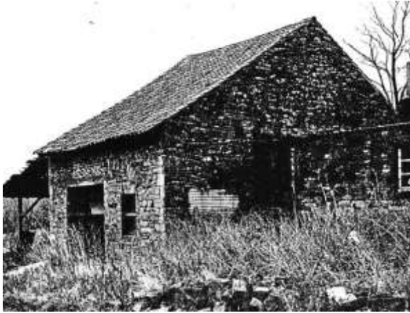
Abb. 10: Ehemaliges Kesselhaus am Schacht Rudolf der Zeche Oberleveringsbank
