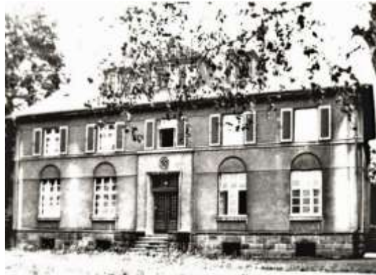
Abb. 12: Verwaltungsgebäude Vereinigte Trappe
