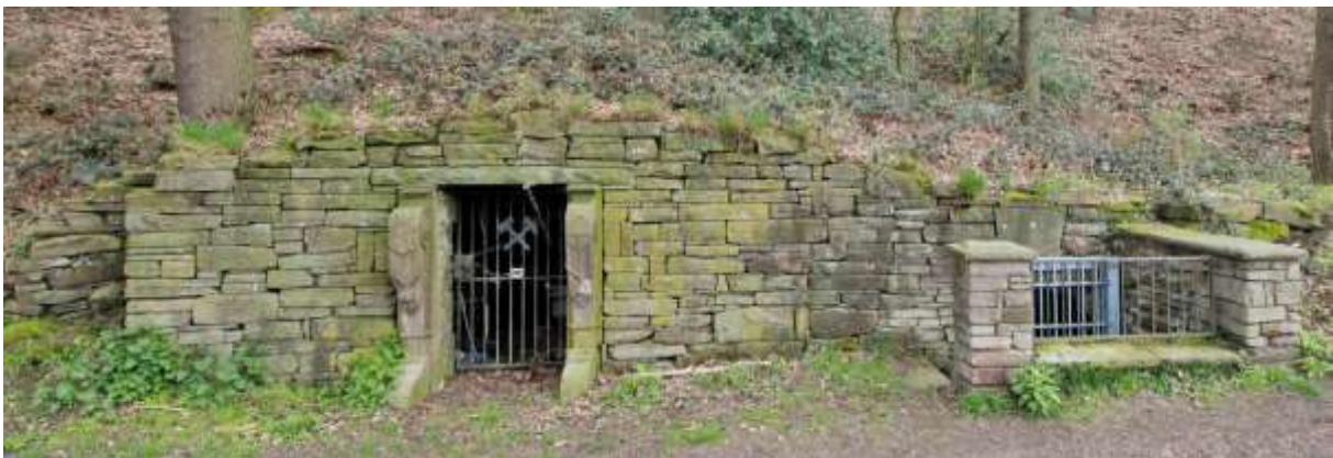
Abb. 17: Gezähkammer (links) und Fahrschachtzugang (rechts)
